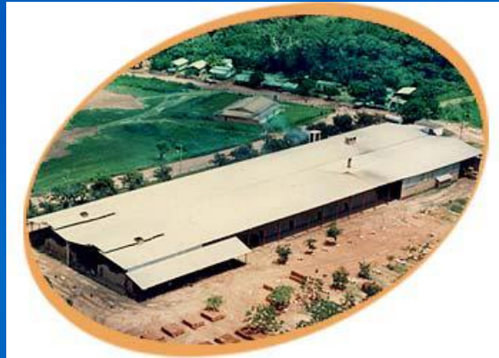
Telheiro para secagem de tijolos
