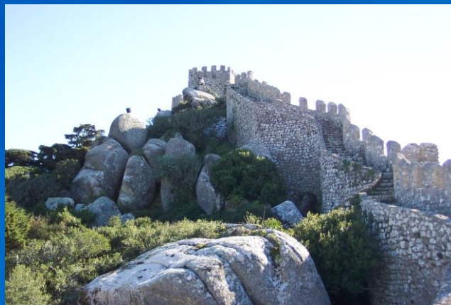
Exemplos de paredes de pedras com o emprego do adobe como aglomerante
