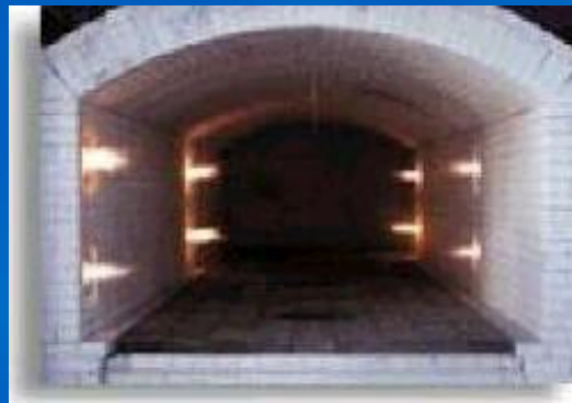
Interior do forno de túnel
