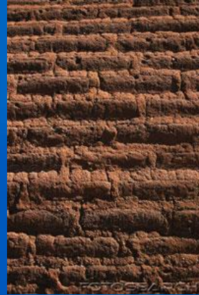
Exemplos de paredes com o emprego do adobe
