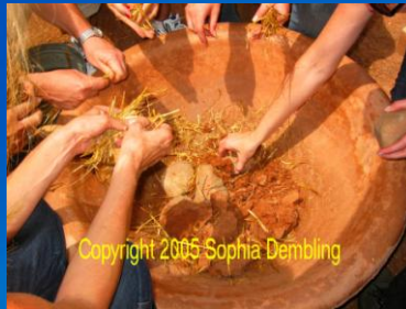
Palha sendo misturada ao barro na formação do Adobe
