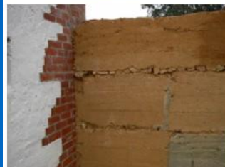
Construção de parede em adobe
